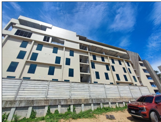
รูปที่ 3.2-3 การก่อผนังอาคารเพื่อใช้สำหรับกันเสียงช่วงตกแต่ง
